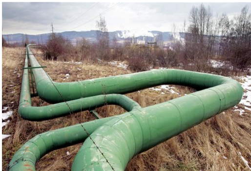
Obr. 3 U-kompenzátor potrubí
