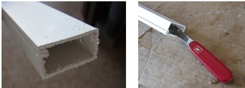
Obr. 5. Otřepy vzniklé při řezání jdou lehce seříznout nožem.
